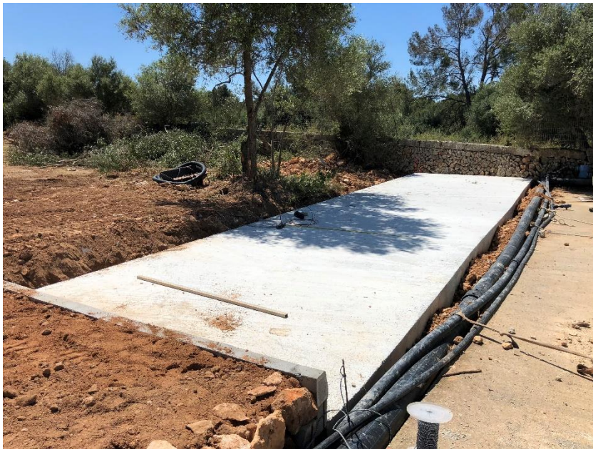
Abb. Betonplatte für die UF
