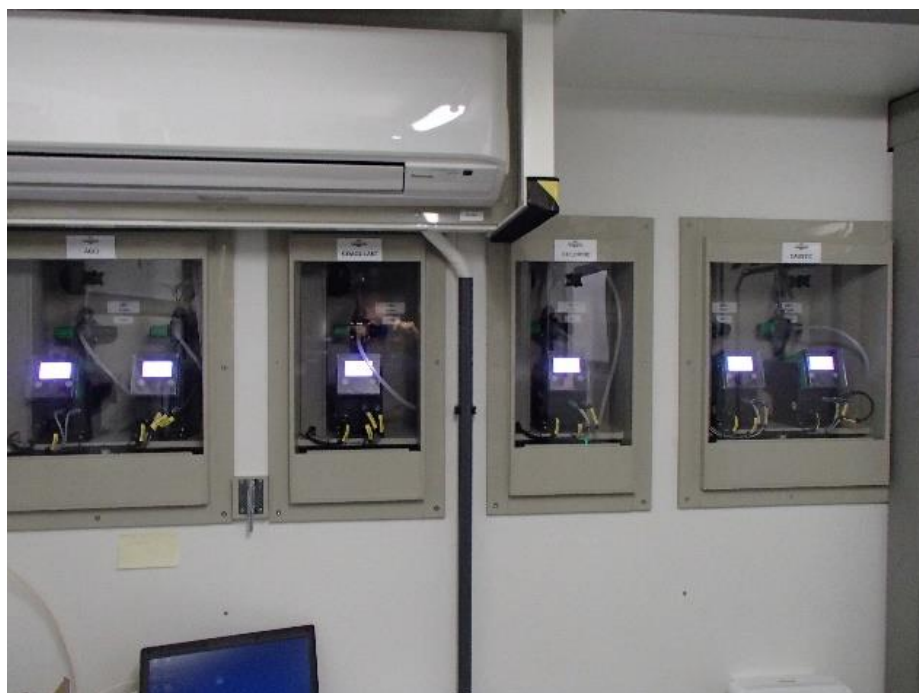
Abb. Integrierte Dosierpumpen für verschiedene Zusätze
