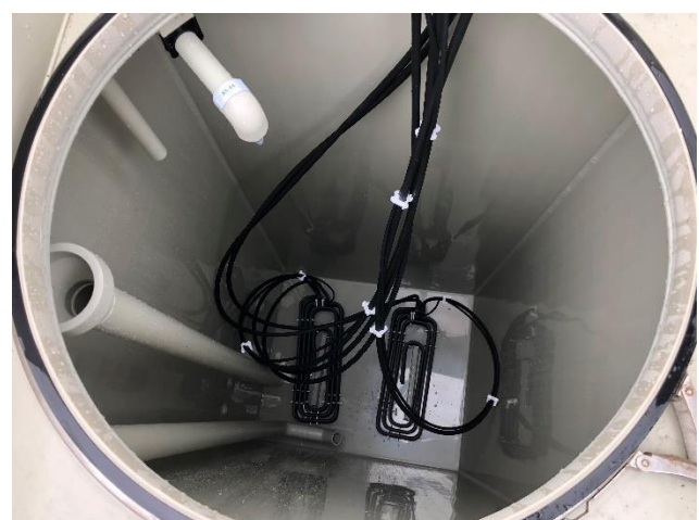
Abb. CIP-Ansetzbehälter (m. Heizung)
