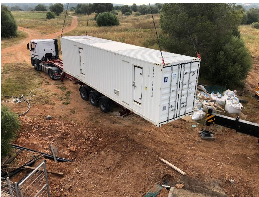
Abb. UF am „Haken“ für die Positionierung auf das Fundament
