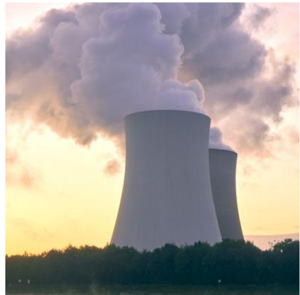
Abbildung 3: Kühlturm eines Kraftwerks als Beispiel für einen offenen Kühlkreislauf
