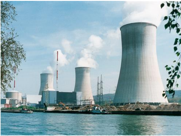
Abbildung 23: Naturzugkühltürme eines Kraftwerkes
