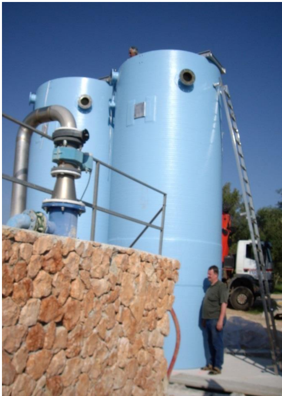
Abbildung 14: Große Sandfilter bei einem Kunden auf Mallorca
