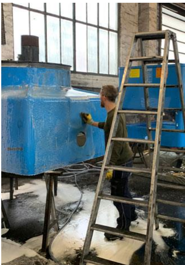
Abbildung 301: Mitarbeiter der aqua-Technik Beratungs GmbH bei der Kühlturmreinigung und Instandsetzung
