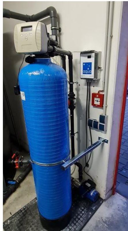
Abbildung 15: Kleiner Einzelkiesfilter zur Bypassfilterung
