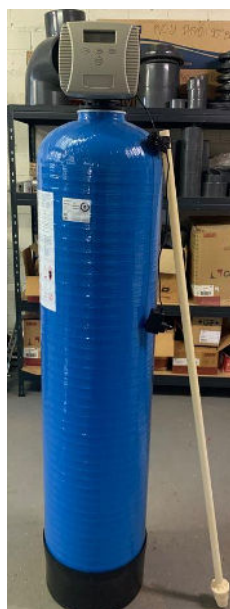
Abbildung 20: Einfacher Aufbau einer Einzelanlage – GFK-Drucktank, Zentralsteuerventil, Rohr mit unterer Düse
