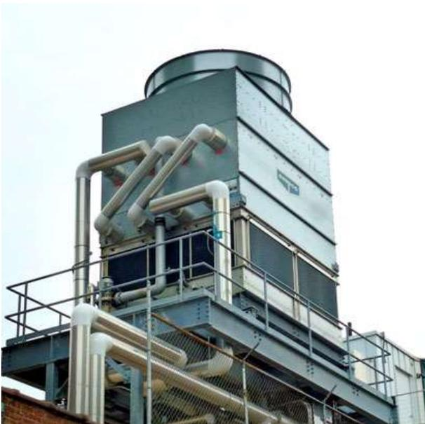
Abbildung 2: Verdunstungskühlanlage (VDKA) als Beispiel für einen offenen Kühlkreislauf
