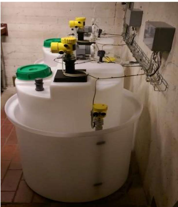
Abbildung 10: Dosieranlage für Chemikalien
