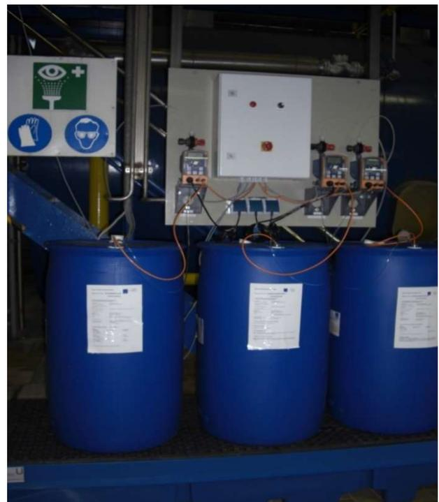
Abbildung 11: Dosierstation für Chemikalien
