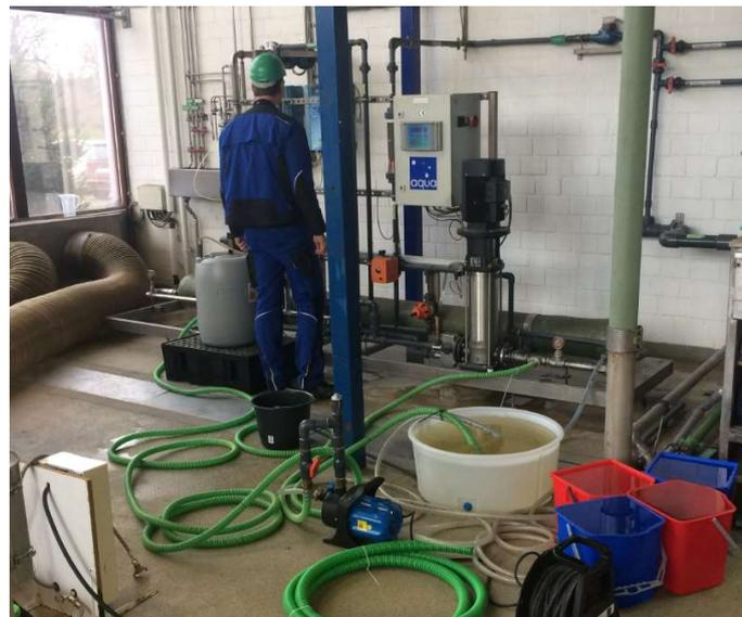
Abbildung 19: Reinigung und Wartung einer UO-Anlage
