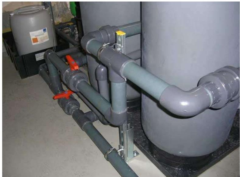
Abbildung 17: Verrohrung eines Aktivkohlefilters mit BIRM Filtermaterial
