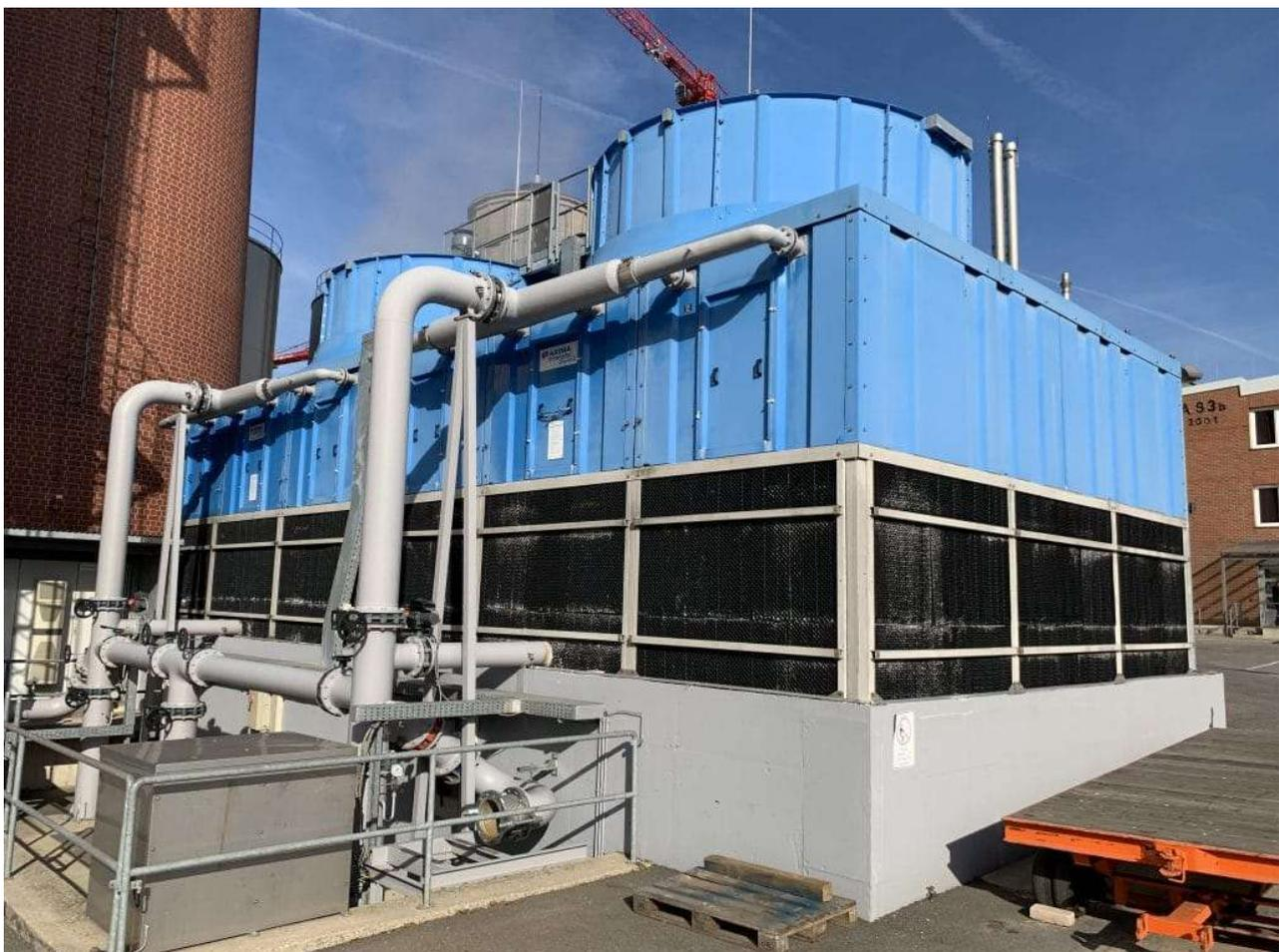
Abbildung 255: Verdunstungskühlanlage („Kühlturm“) eines Kunden in der Industrie
