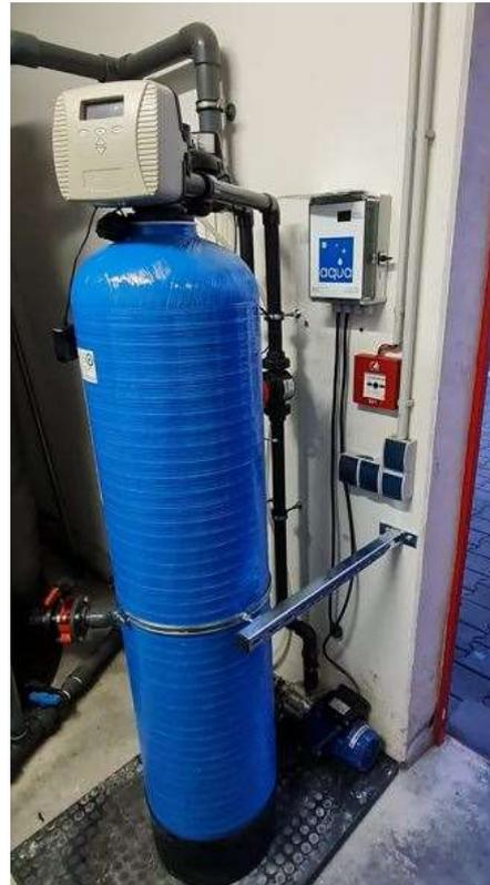
Abbildung 15: Kleiner Einzelkiesfilter zur Bypassfilterung
