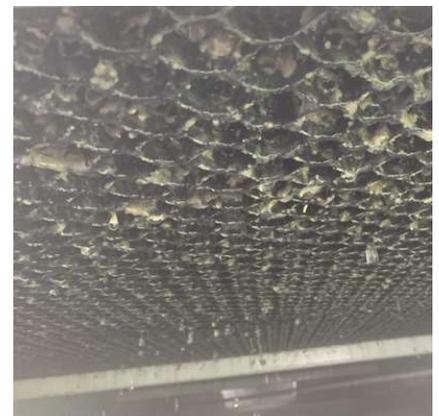
Abbildung 9: Füllkörper- bzw. Kühlturmeinbauten mit Biofilm und Ablagerungen
