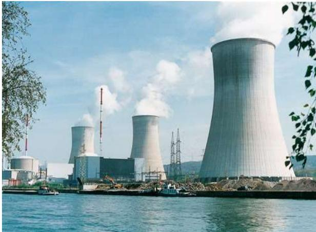
Abbildung 23: Naturzugkühltürme eines Kraftwerkes
