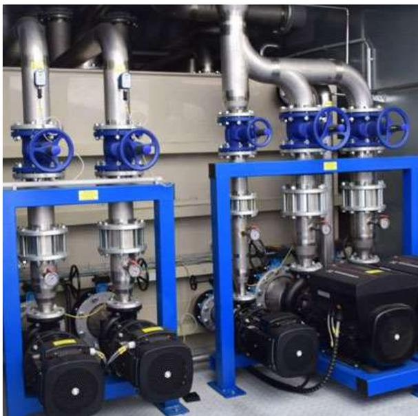
Abbildung 4: Pumpstation mit Verbraucher- und Kühlturmpumpen eines Kühlturms
