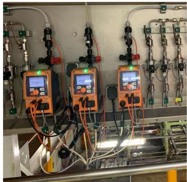
Abbildung 5: Dosierstation mit gammaX-Pumpen
