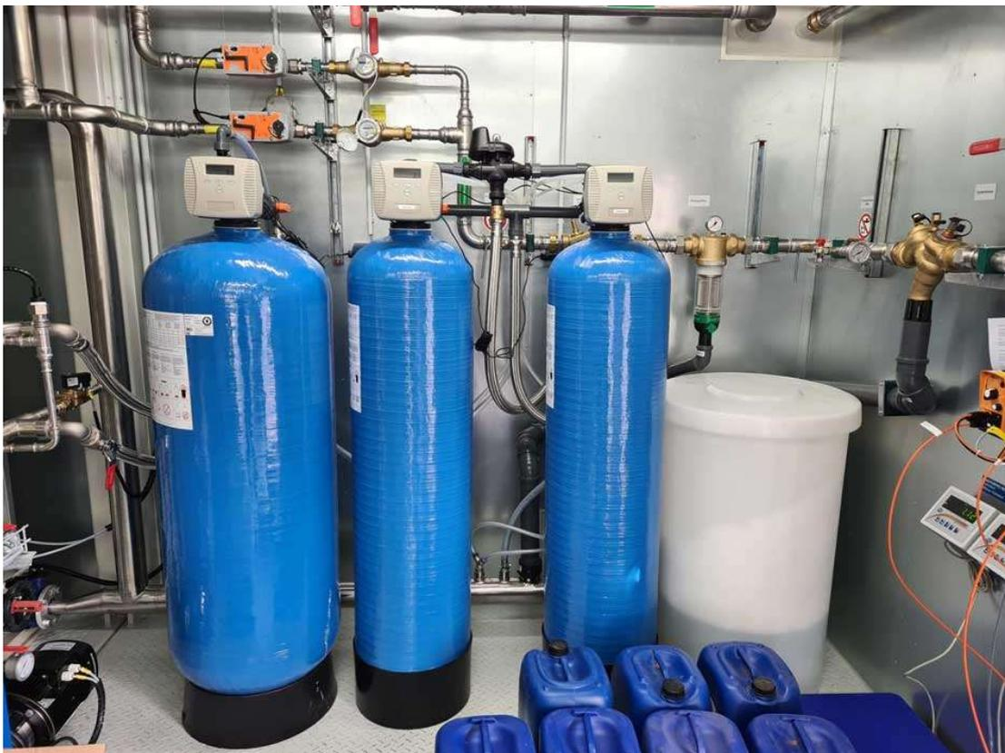
Abbildung 22: Doppel-Enthärtungsanlage (rechts) und Einzelkiesfilter (links) bei einem Kunden im Container verbaut
