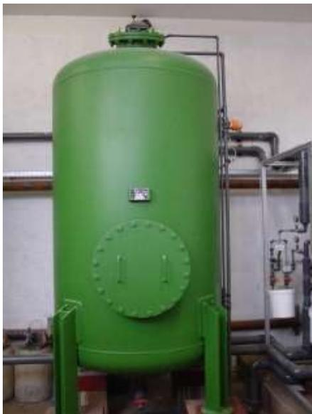
Abbildung 16: Aktivkohlefilter für Rohwasser 15 m<sup>3</sup>/h
