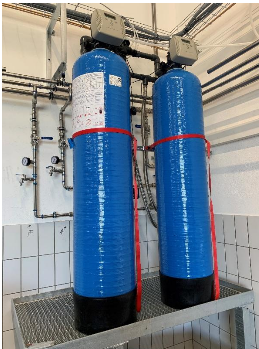
Abbildung 3: Doppel-Enthärtungsanlage auf Montagegestell
